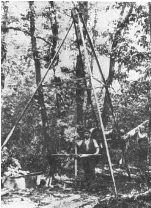
Kutatófúrás kézi fúróberendezéssel
