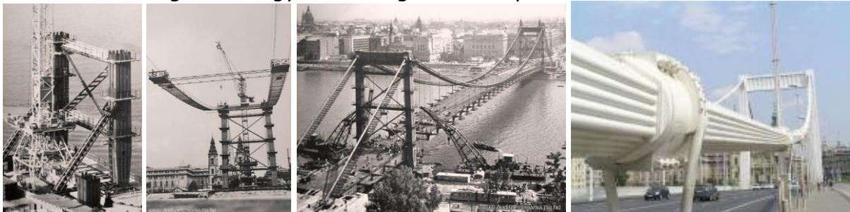
Budapest, Erzsébet híd építése 1960-64 foto: www.budapestmania.fw.h A híd felfüggesztése
